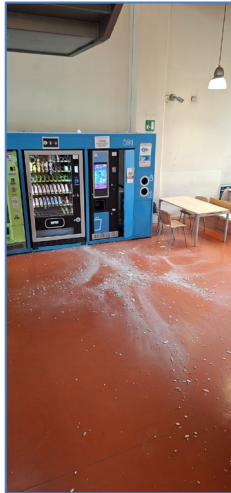
Vista generale dell'area interessata dalla caduta.
