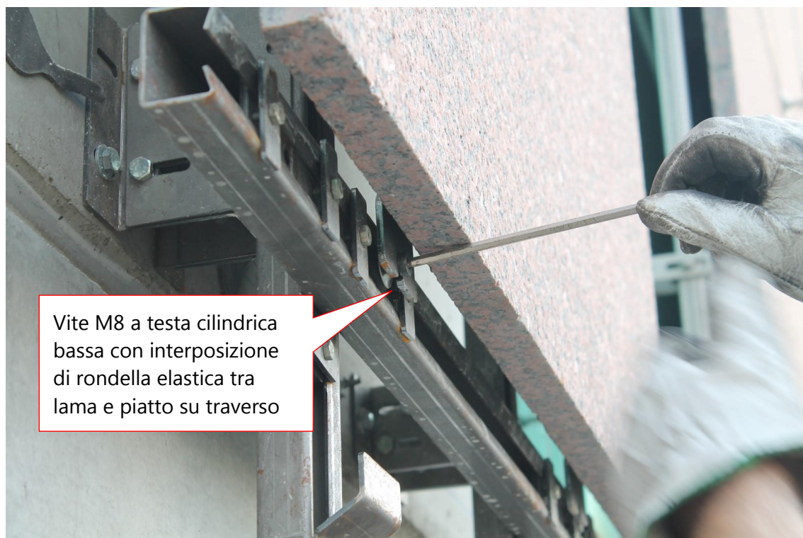
Figura 34. Fissaggio lastra su traverso inferiore. Ripetere operaio su traversi superiori (fase 4)
