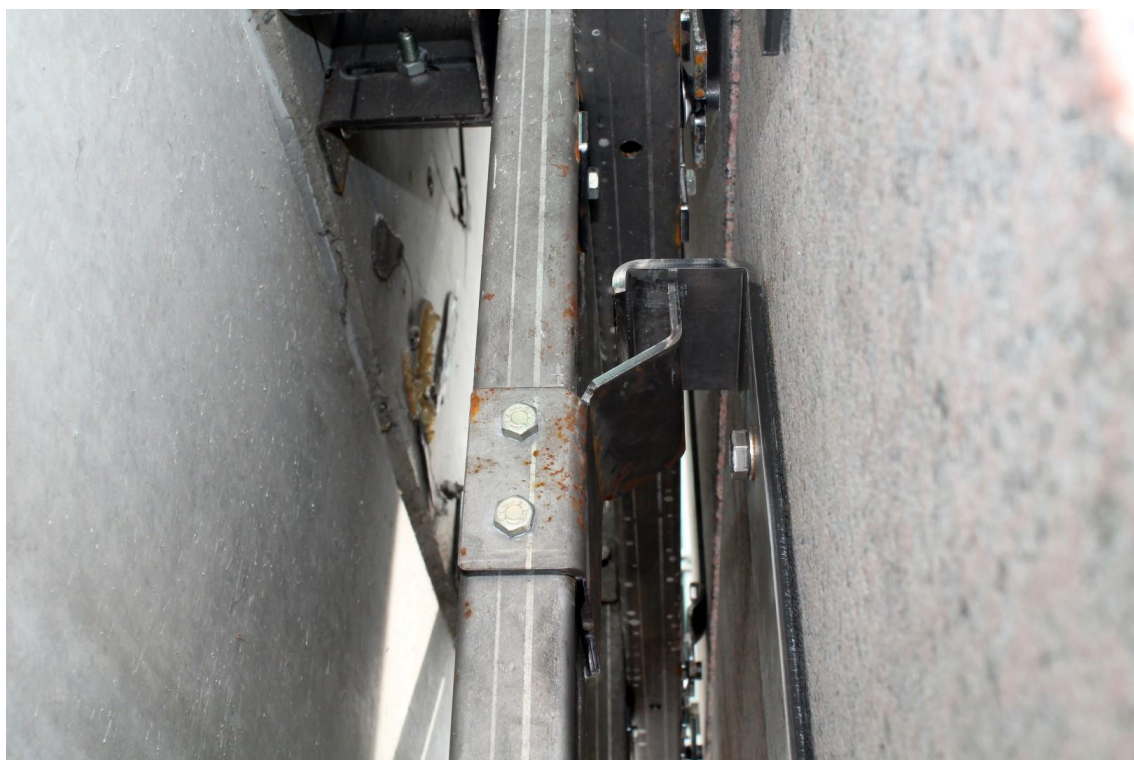
Figura 33. Appoggio lastre su mensole intermedie collegate ai montanti
