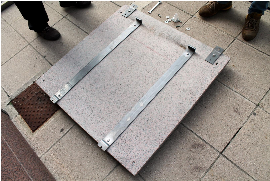
Figura 31. Preparazione lastra (fase 1)
