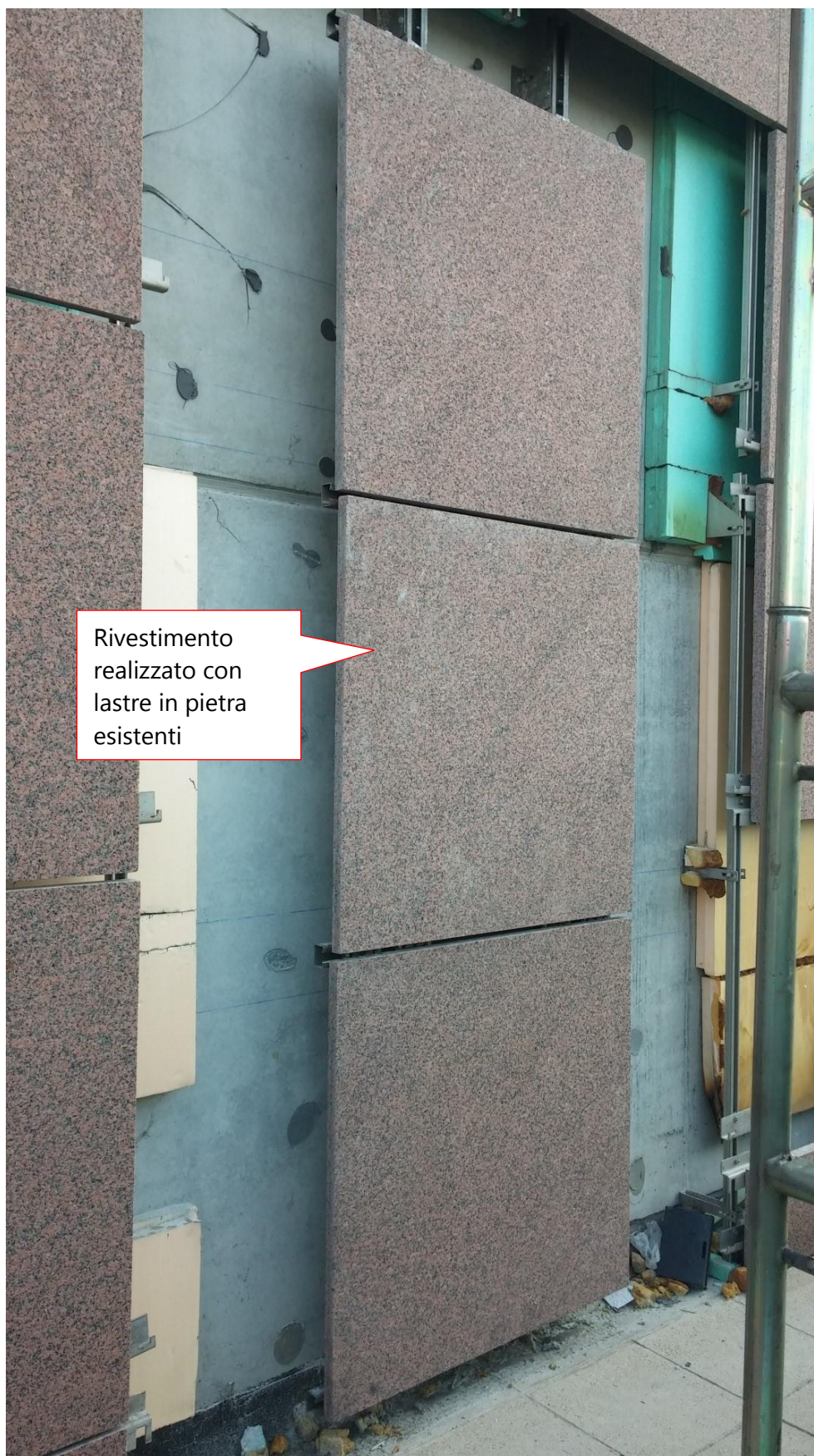
Figura 36. Verifica dimensione giunti e complanarità della superficie (fasi 5 e 6)
