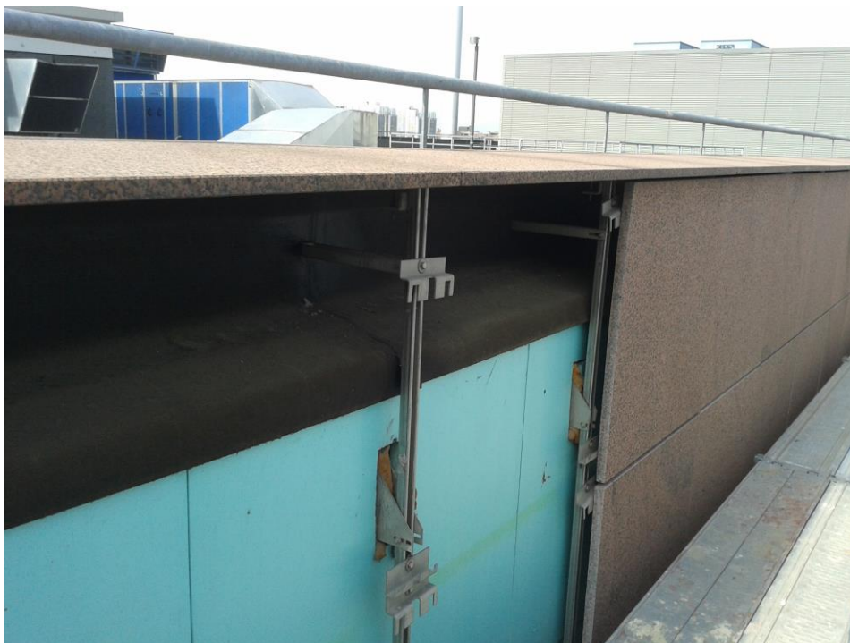
Figura 24. chiusura superiore di copertura
