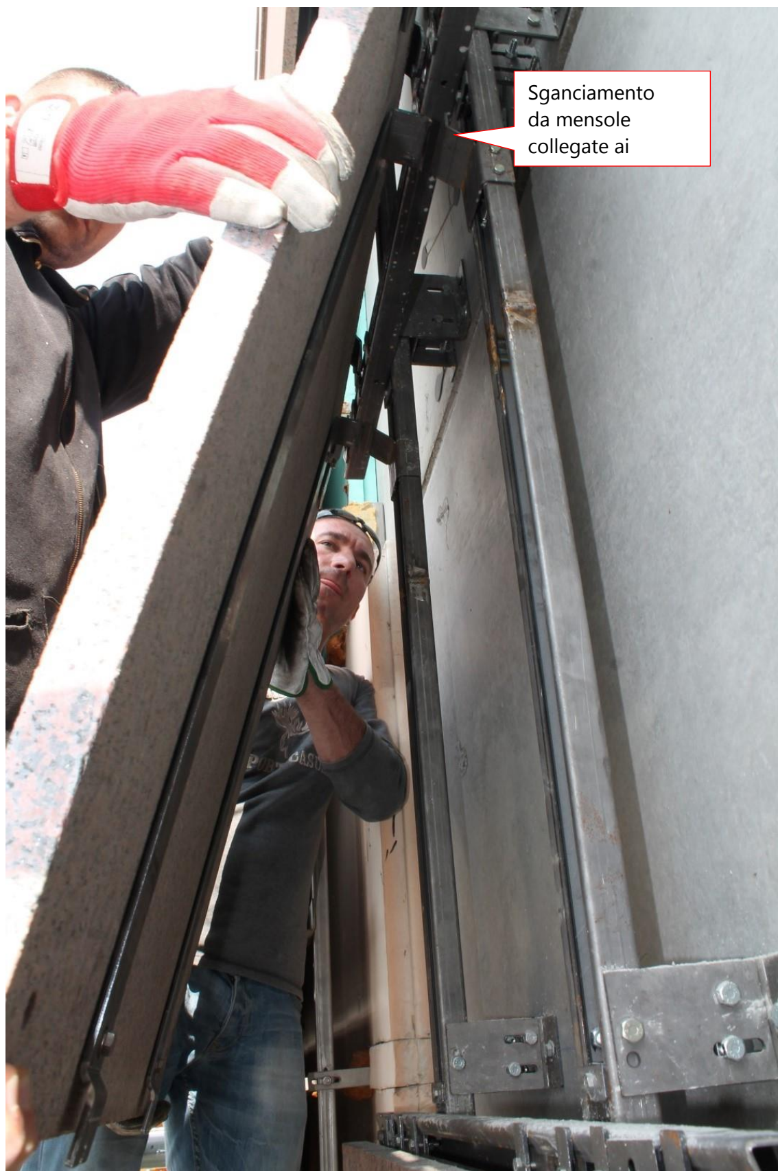
Figura 38. Slittamento e sgancio lastra (fase 3)
