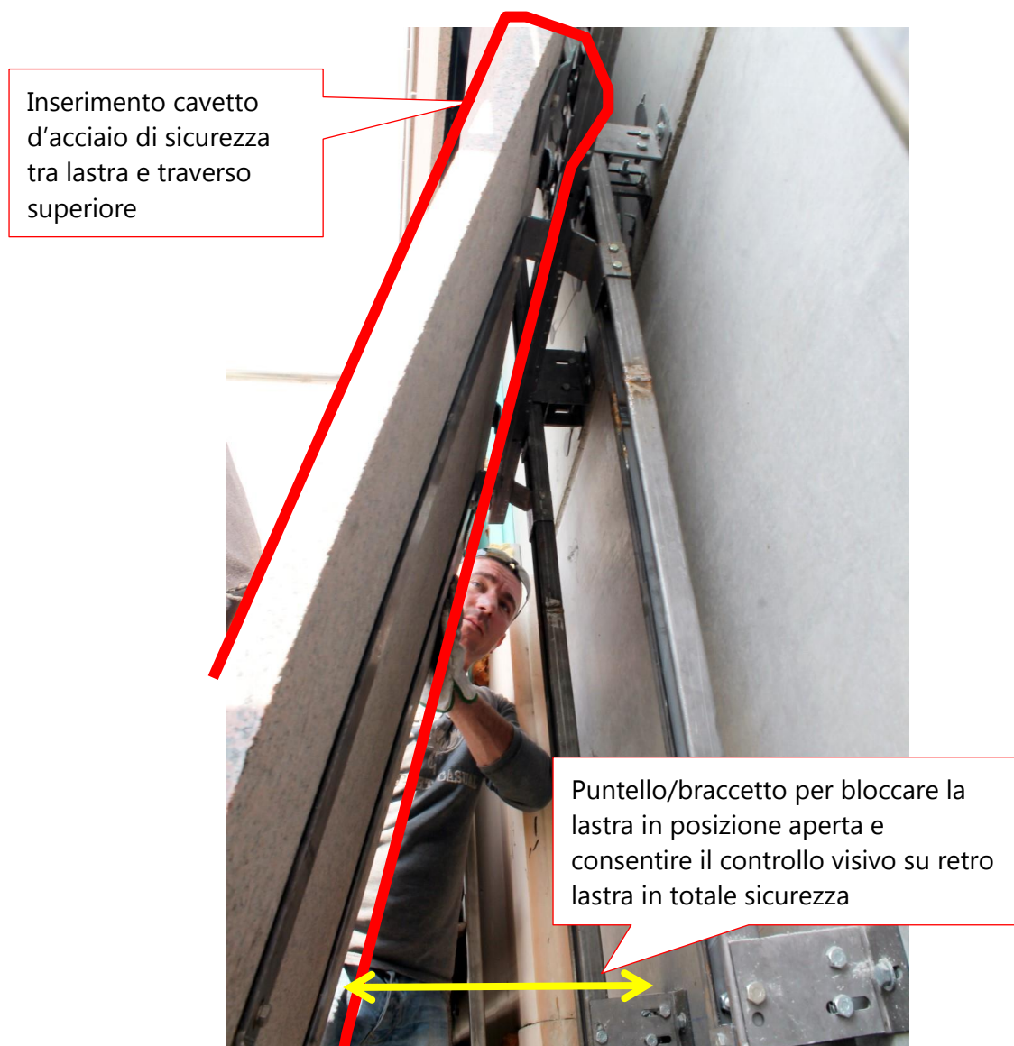
Figura 41. Manutenzione ordinaria lastra: apertura inferiore a vasistas facendo perno su viti fissate su traverso superiore dopo aver sganciato la lastra dalle mensole intermedie presenti sui montanti e dopo aver installato num. 2 cavetti di acciaio lastra e traverso superiore della sottostruttura. Prevedere inoltre l'installazione di due braccetti/puntelli per bloccaggio lastra ed ispezione in sicurezza (fase 5)
