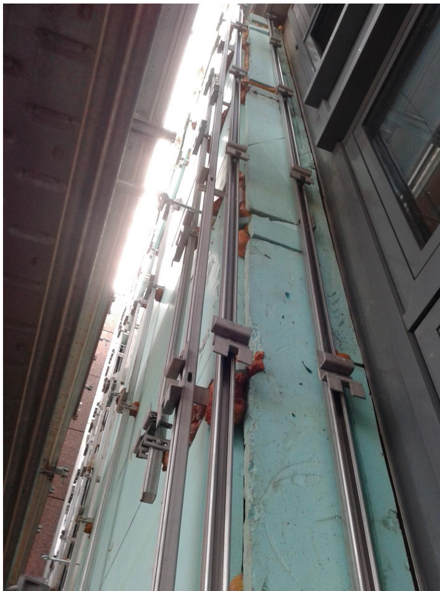
Figura 23. Sottostruttura su imbotti laterali
