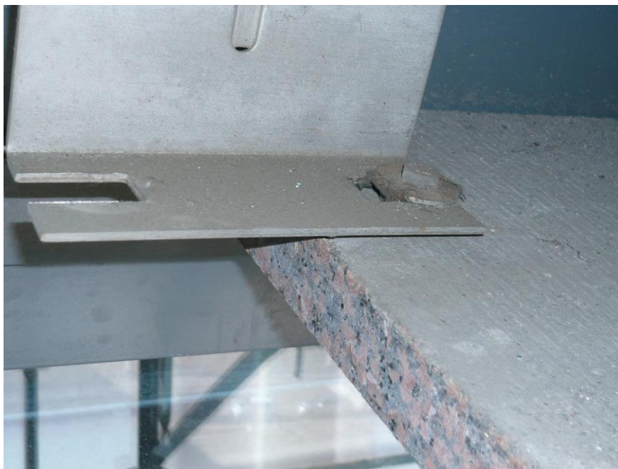
Figura 26. Ancoraggio imbotte superiore su sottostruttura.
