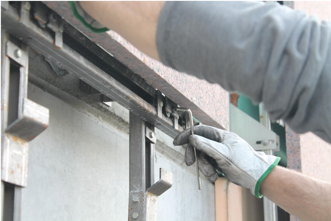
Figura 37. Svitamento e rimozione viti su traverso inferiore e superiore (fase 2).
