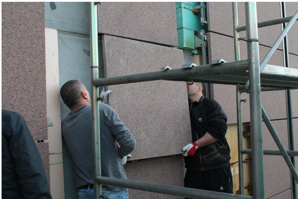
Figura 32. Montaggio singola lastra avendo cura di garantire il pieno appoggio della lastra sulle mensole retrostanti e collegate direttamente al montante (fase 3)
