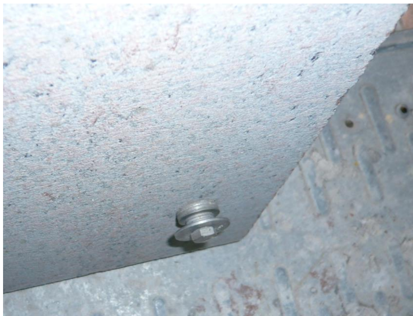
Figura 4. Inserti tipo GSD su lastra (SDF)
