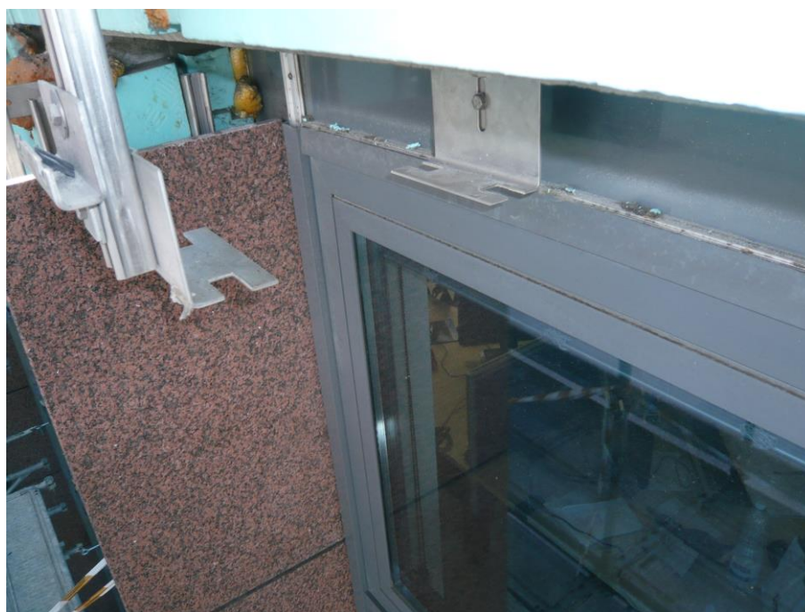
Figura 25. Ancoraggi su imbotte superiore finestrone fronte A
