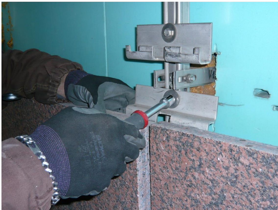
Figura 20. Staffe di ancoraggio lastre
