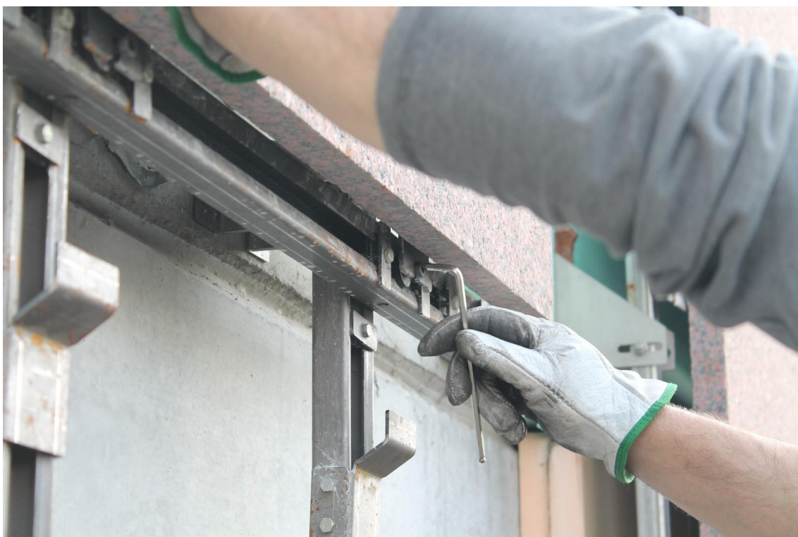
b. Figura 39. Svitamento e rimozione viti su traverso inferiore (fase 1)
