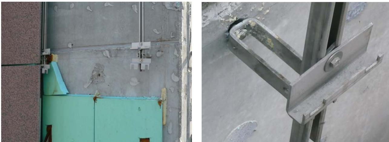
Foto 9 e 10. Particolari dei fori da sigillare sul paramento murario in c.a.
