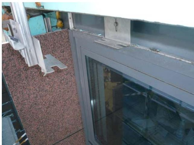
Foto 11 e 12. Particolare di montaggio delle lastre in corrispondenza dei serramenti
