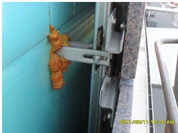
Foto 3 e 4. Particolari della sottostruttura esistente da rimuovere e sostituire
