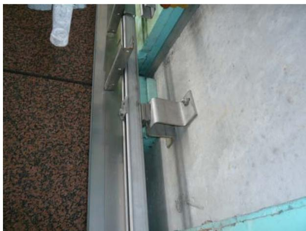
Foto 7 e 8. Particolari delle lastre coibenti e della sottostruttura di ancoraggio sui pannelli prefabbricati in c.a.
