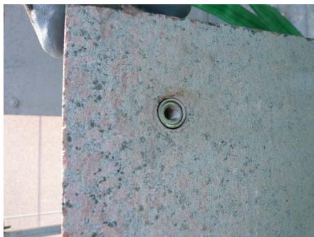
Foto 5 e 6. Particolari dei giunti tra lastre e dei fori di fissaggio retrolastra con inserti a scomparsa
